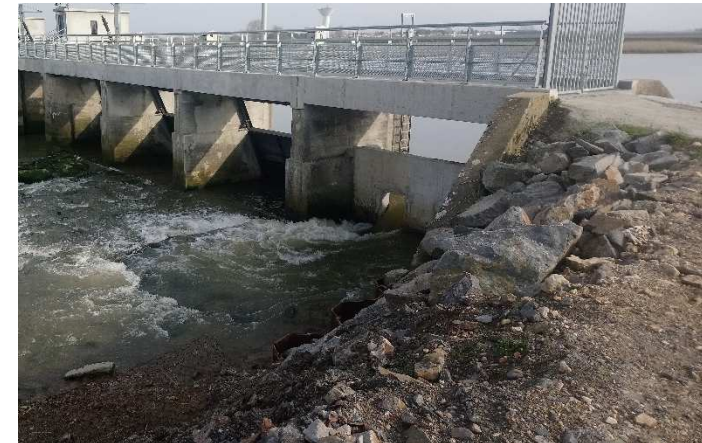
Figure 38 : échancrure sur le barrage du Braud à marée haute, vue amont
