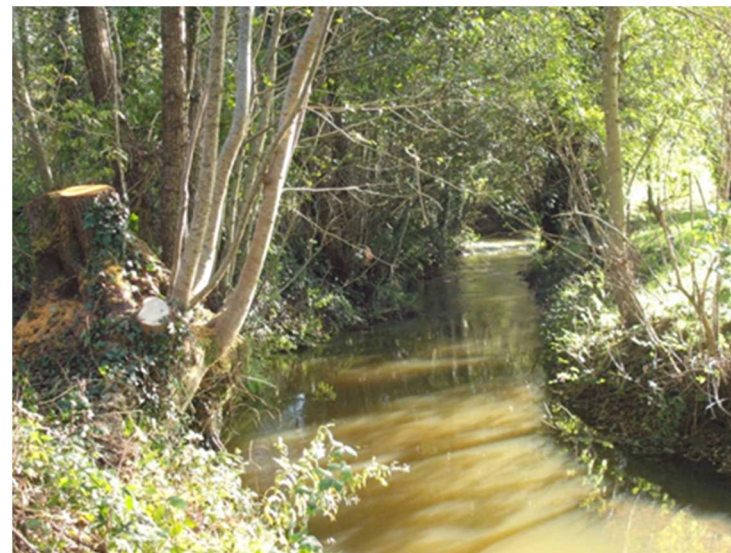
Figure 40 : nettoyage des berges du GRAON
