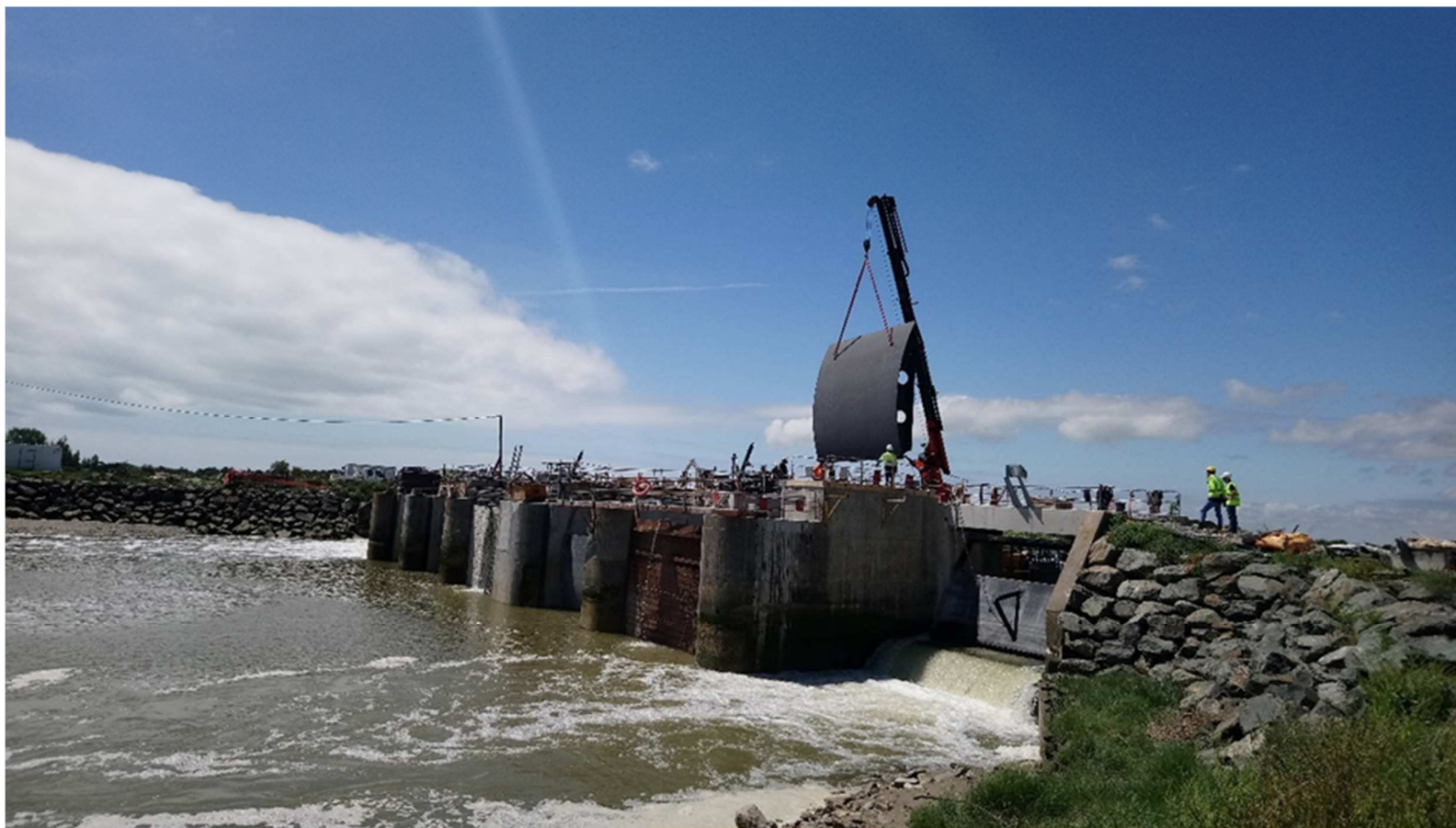
Figure 39 : restauration du barrage estuarien du LAY, vue aval
