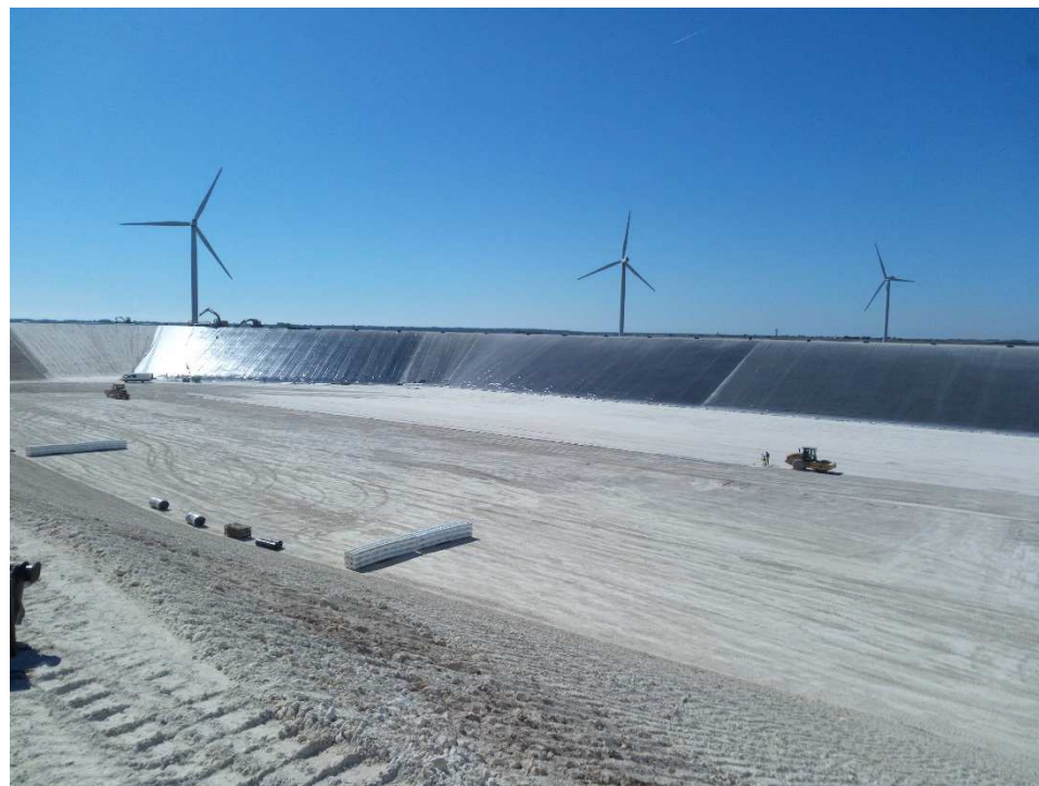
Figure 29 : pose de la géomembrane EPDM – réserve du Bernard (septembre 2018)
